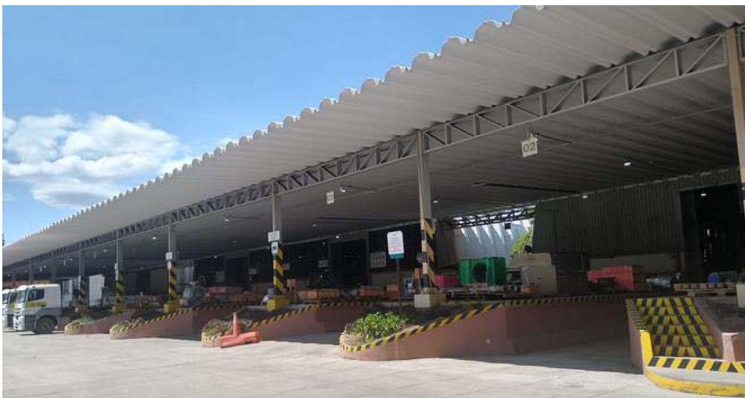
Docas – setor de recebimento de materiais novos em Macaé
