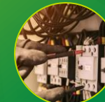
Instalação e Manutenção Elétrica Industrial
