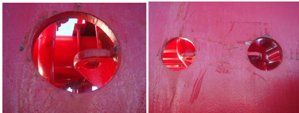
5.7.11.5. Figura: Exemplo de olhais embutidos na chaparia da estrutura do “horse bar”
